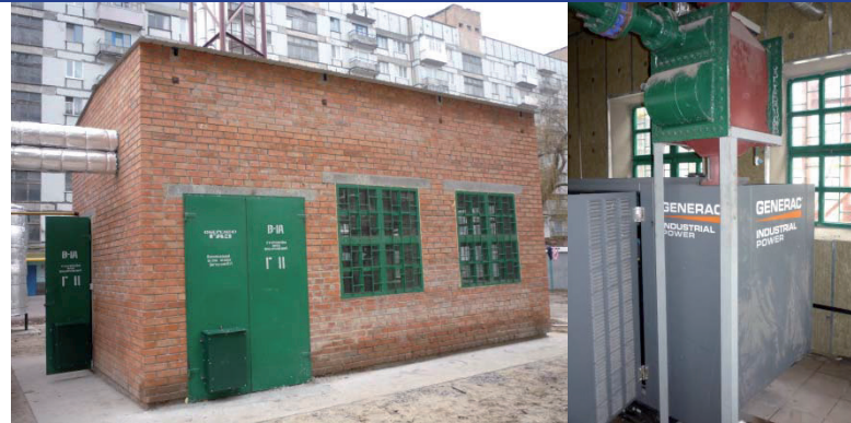
Переобладнання приміщення ЦТП на міні-ТЕЦ
